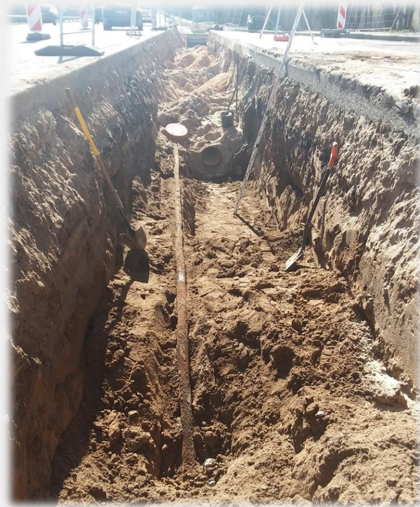
Sadzīves kanalizācijas cauruļvada trases ceļā kabelis, kas nav uzrādīts topogrāfijā
