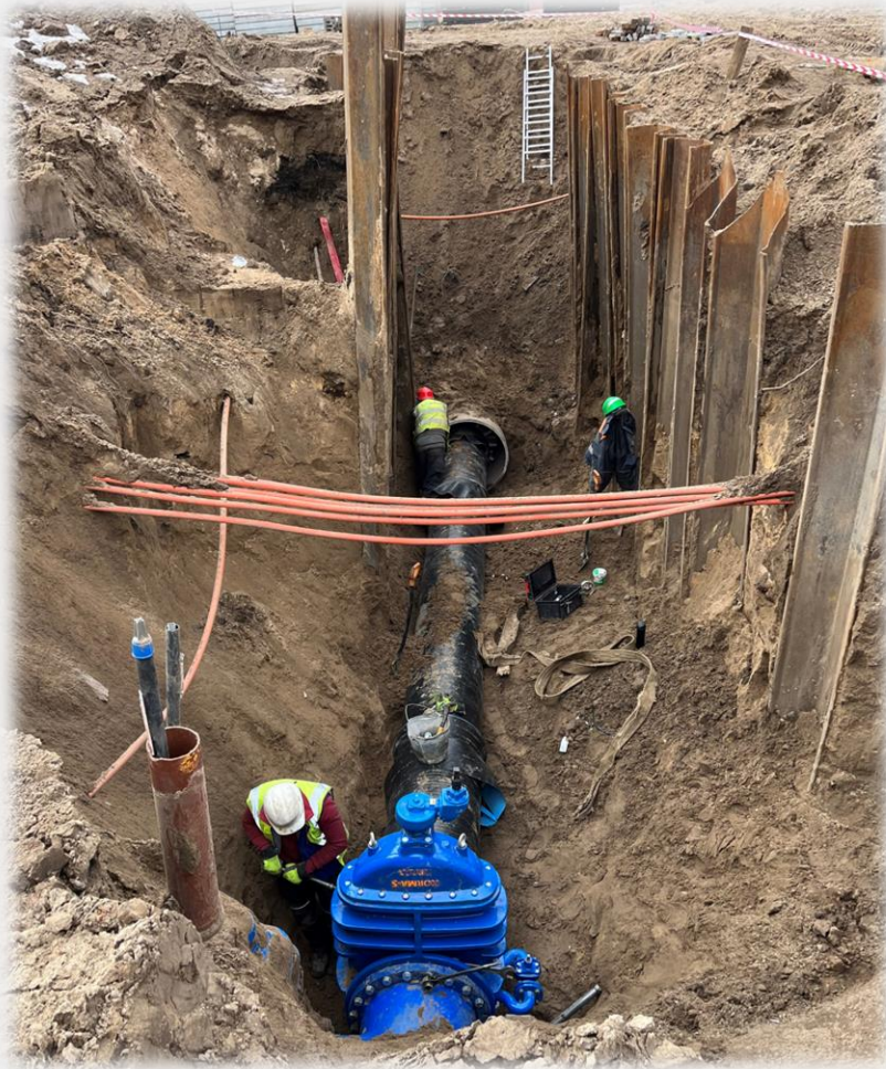
Tranšejas sienu un šķērsojošo komunikāciju stiprināšana
