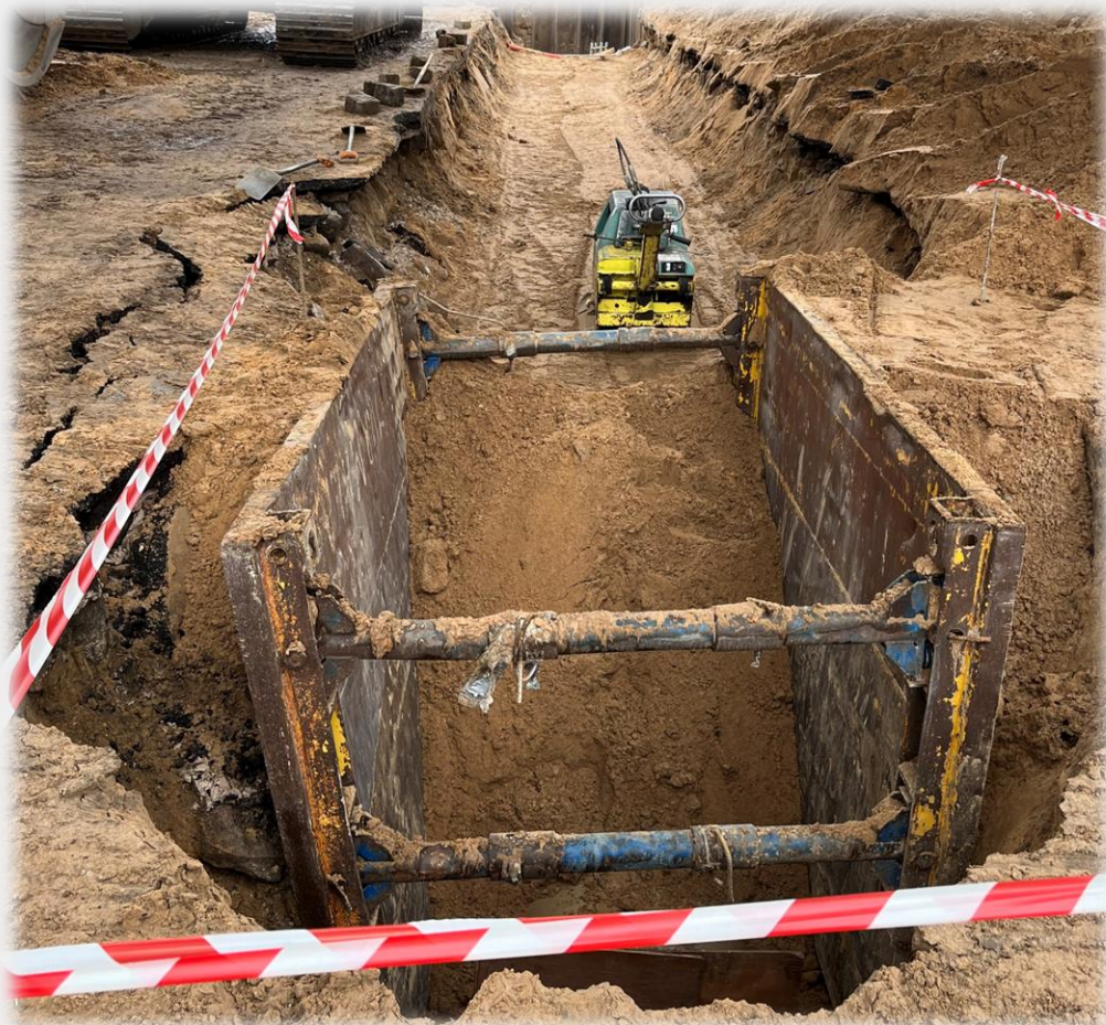
Asfaltbetona malu lūzumi gar būvbedres malām
