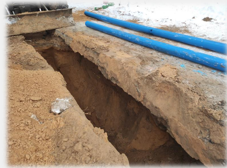
Tranšejas sienu un šķērsojošo komunikāciju stiprināšana
