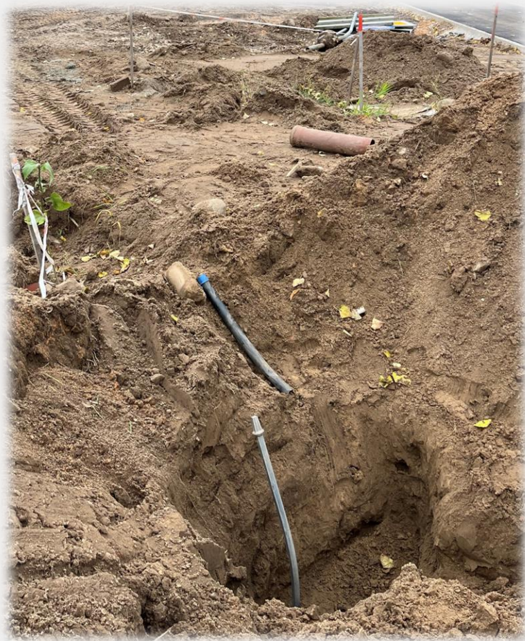
Veicot labiekārtošanas darbus saliekts aizbīdņa kāts
